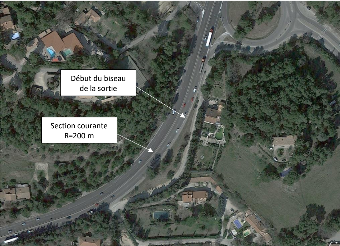
Figure 18 - Vue aérienne de l’échangeur Puyricard (état actuel)
