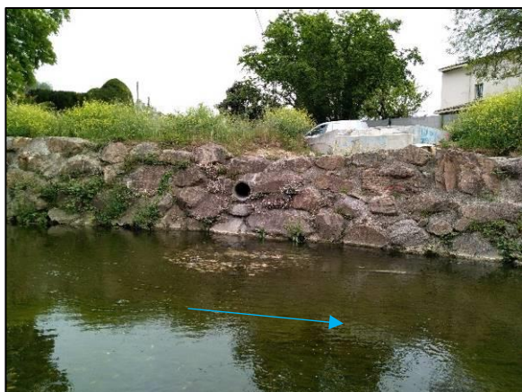
Rejet d'eau pluviale dans l'enrochement situé en rive gauche de la Brague
