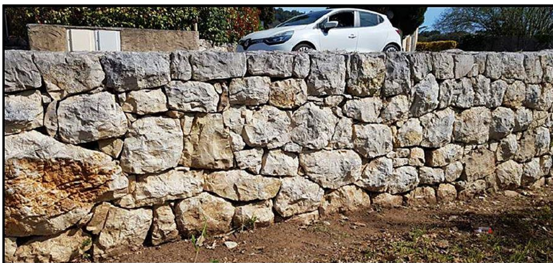
Figure 9 : Mur en pierres situé à proximité de la zone de projet. Le parement en pierres à bâtir ourdées non jointées de l'ouvrage de confortement sera similaire à cet exemple.
